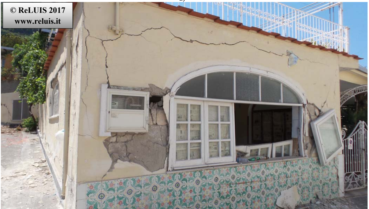
Edificio in Muratura - Via D'Aloisio Località la Rita – Casamicciola Terme Lesioni nel piano della parete :a) Google street view pre-evento; b) immagine post-evento sismico.
