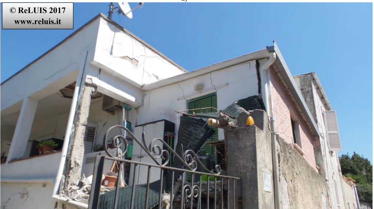
Edificio in Muratura - Via D'Aloisio Località la Rita – Casamicciola Terme Ribaltamento della facciata :a) Google street view pre-evento; b) immagine post-evento sismico.
