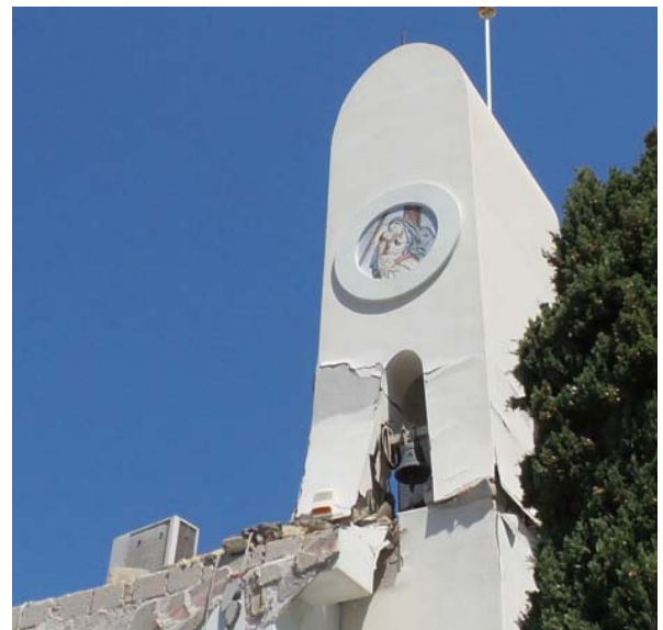
Chiesa Santa Maria dei Suffraggi detta del Purgatorio - Via D'Aloisio Località la Rita – Casamicciola Terme Danno alla cella campanaria :a) Google street view pre-evento; b) immagine post-evento sismico.
