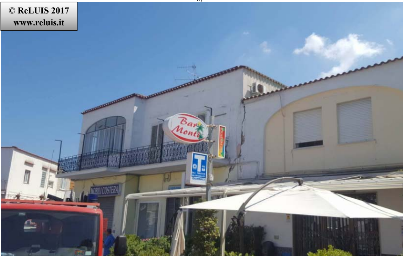
Edifici in Muratura - Via Montecito, Piazza Maio – Casamicciola Terme Martellamento tra edifici di differente altezza:a) Google street view pre-evento; b) immagine post-evento sismico.
