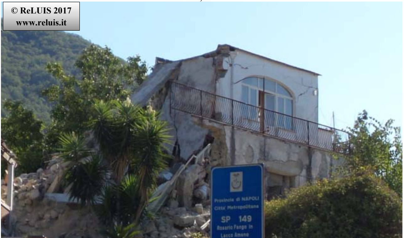
Edificio in Muratura - Via Borbonica Località Fango – Lacco Ameno Crollo parziale :a) Google street view pre-evento; b) immagine post-evento sismico.
