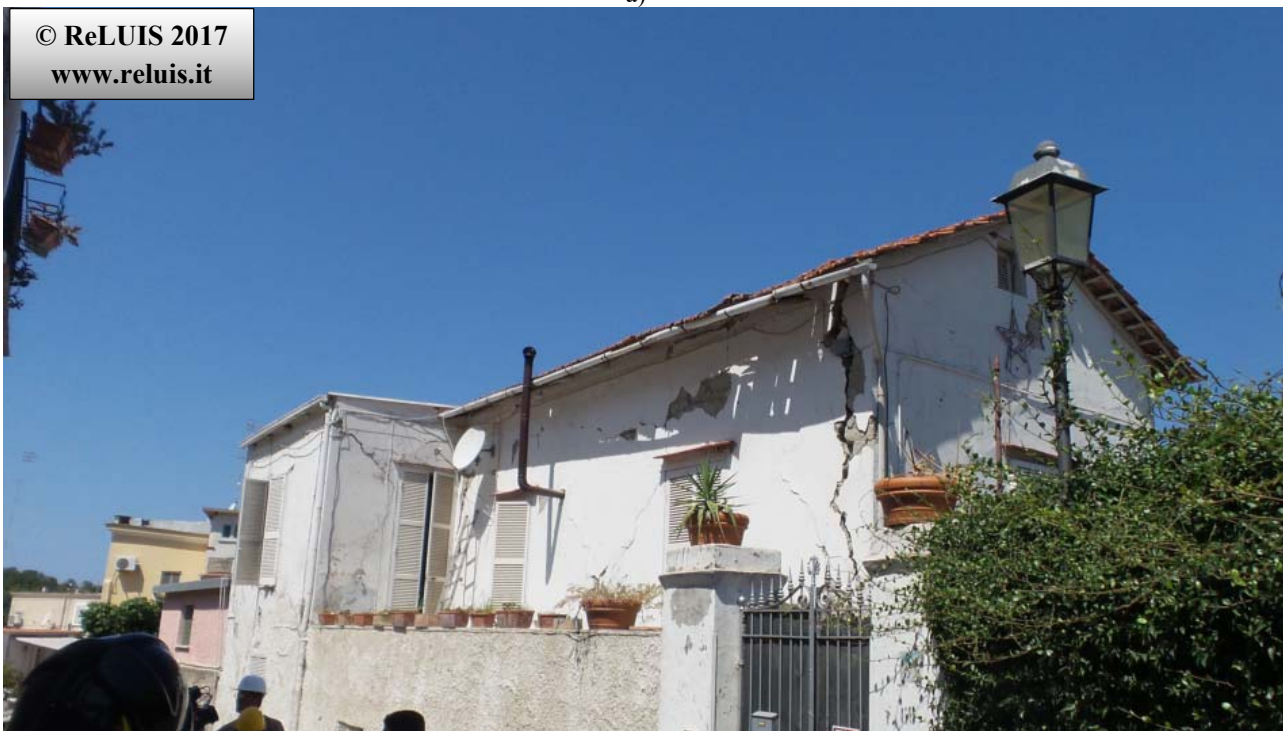
Edificio in Muratura - Via D'Aloisio Località la Rita – Casamicciola Terme Ribaltamento della facciata :a) Google street view pre-evento; b) immagine post-evento sismico.
