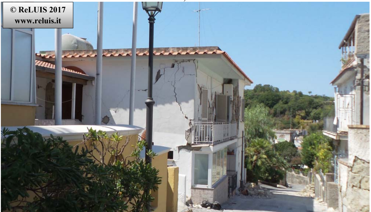
Edificio in Muratura - Via D'Aloisio Località la Rita – Casamicciola Terme Ribaltamento di cantonale :a) Google street view pre-evento; b) immagine post-evento sismico.
