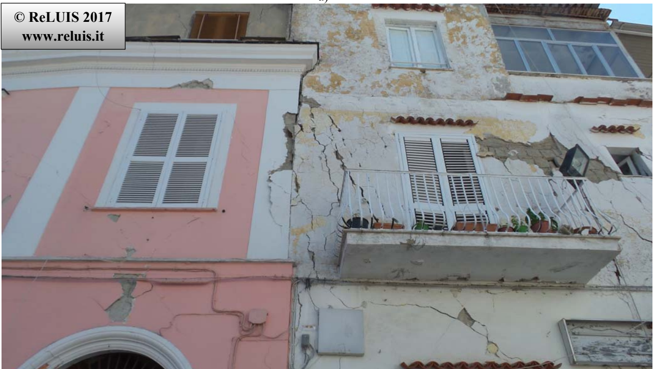
Edifici in Muratura - Via Speziera, Piazza Maio – Casamicciola Terme Interazione tra edifici contigui: a) Google street view pre-evento; b) immagine post-evento sismico.
