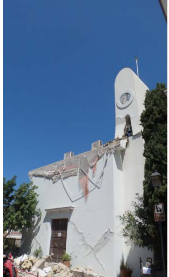
Chiesa Santa Maria dei Suffraggi detta del Purgatorio - Via D'Aloisio Località la Rita – Casamicciola Terme Ribaltamento della sommità della facciata :a) Google street view pre-evento; b) immagine post-evento sismico.
