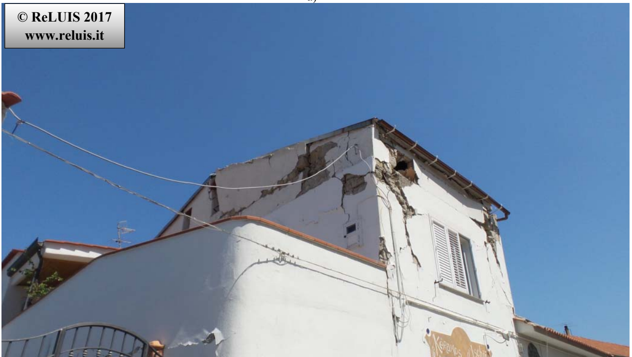
Edificio in Muratura - Via D'Aloisio Località la Rita-Casamicciola Terme Ribaltamento di facciata :a) Google street view pre-evento; b) immagine post-evento sismico.
