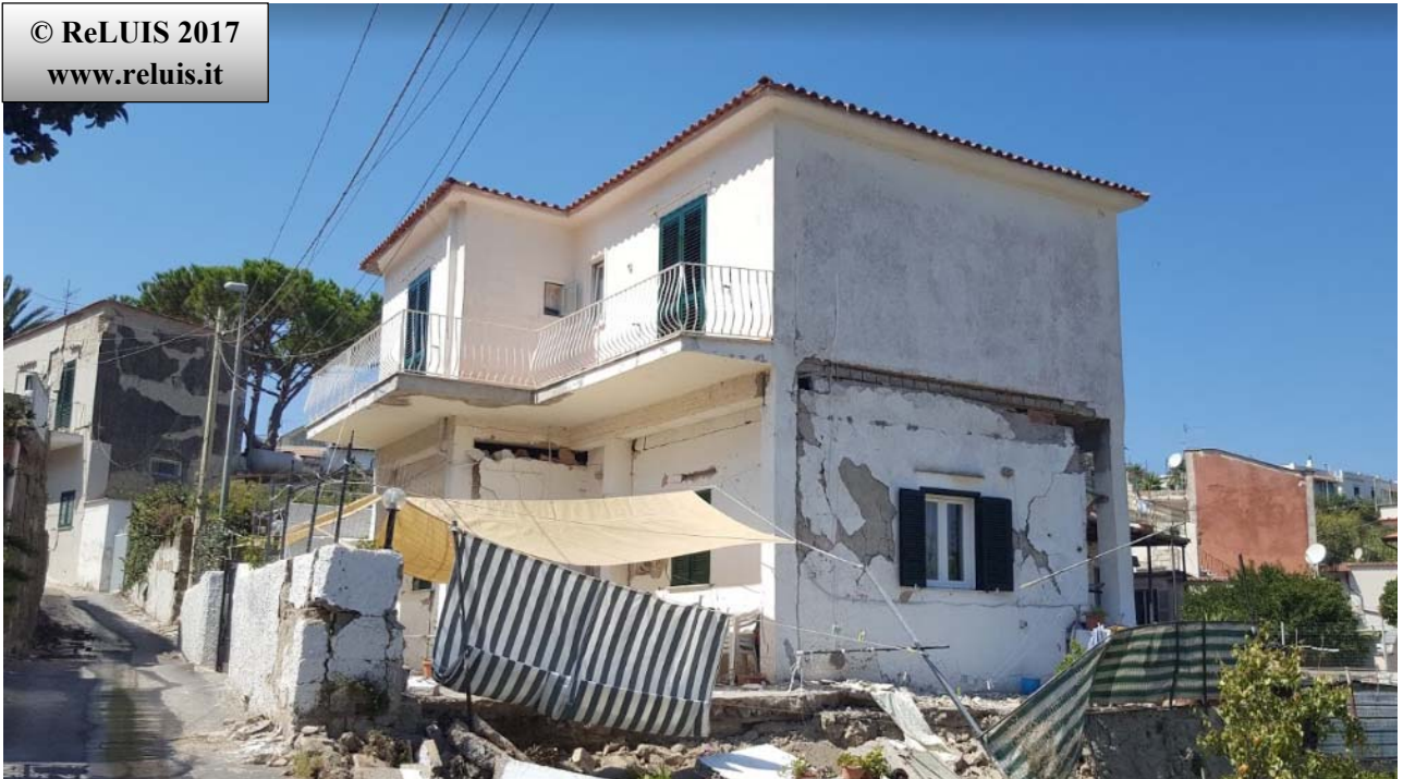
Edifici in Cemento Armato- Via Ottringolo, Piazza Maio – Casamicciola Terme Distacco Tamponatura
